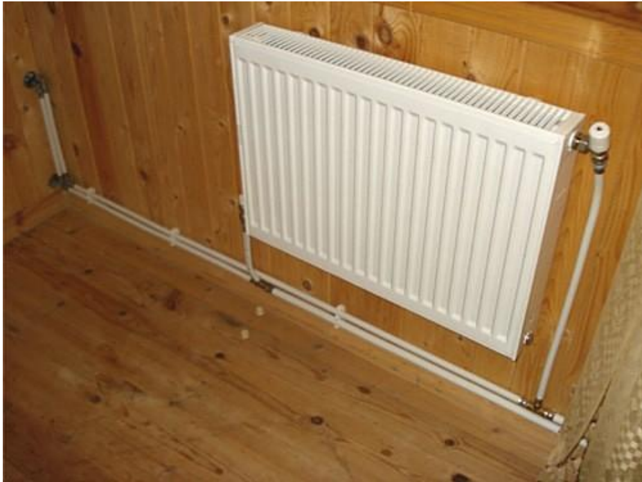
Şəkil 1.22. Polipropilen borulardan ibarət istilik sistemi
