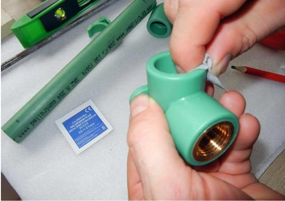
Şəkil 2.31. Boru və fitinqlərin qaynaqdan öncə təmizlənməsi
