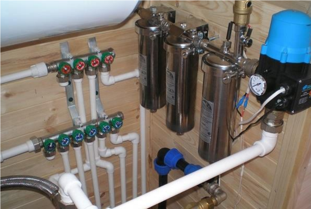
Şəkil 1.11. Suyun ölçü cihazlarına və kollektora qoşulması
