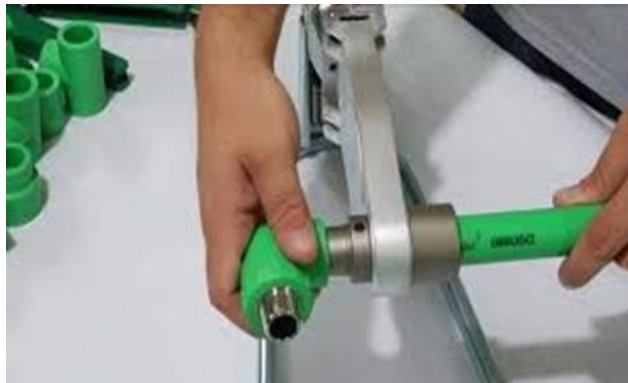
Şəkil 2.35. Boru və fitinqin qızdırıcı gilzə salınması
