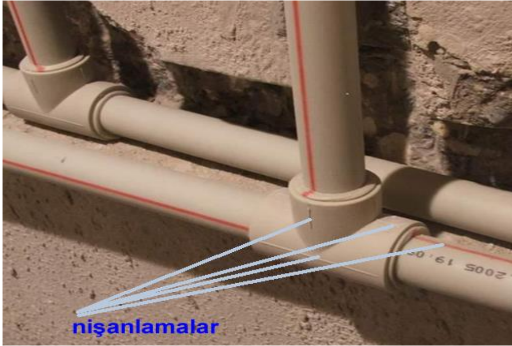
Şəkil 3.20. Standart boru məmulatlarında nişanlanma elementləri
