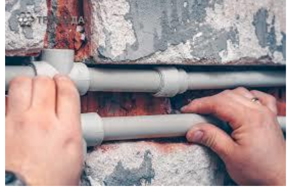
Şəkil 1.2. Suvaqaltı xətlər
