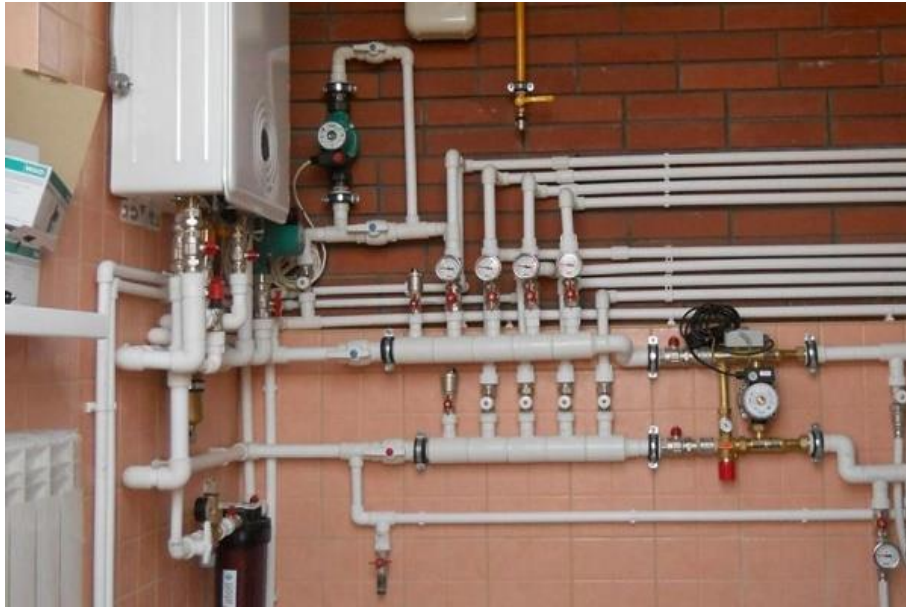
Şəkil 1.9. Polipropilen borulardan yığılmış şaxəli su qızdırıcı sistemi
