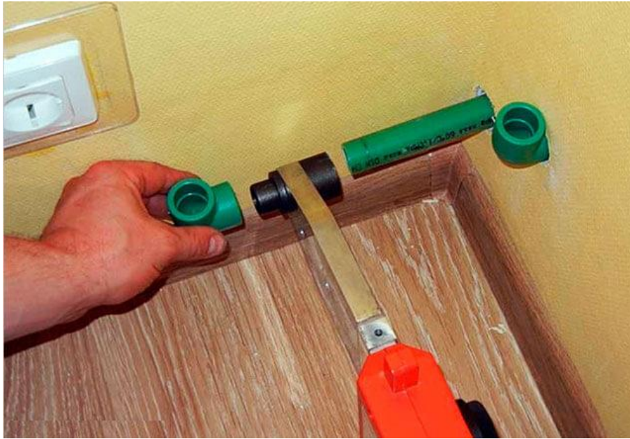
Şəkil 3.12. Künclərdə qaynaq işinin aparılması
