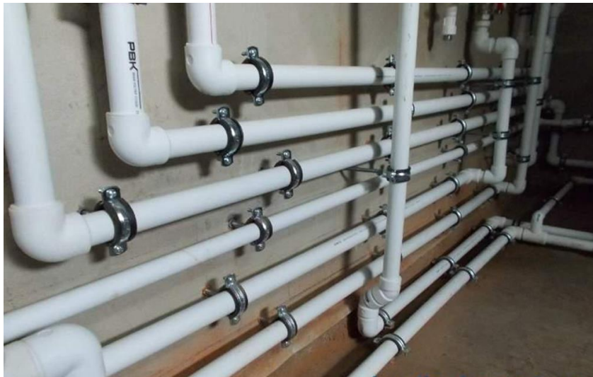
Şəkil 3.19. Boruların xamıtlar vasitəsilə divara bərkidilməsi
