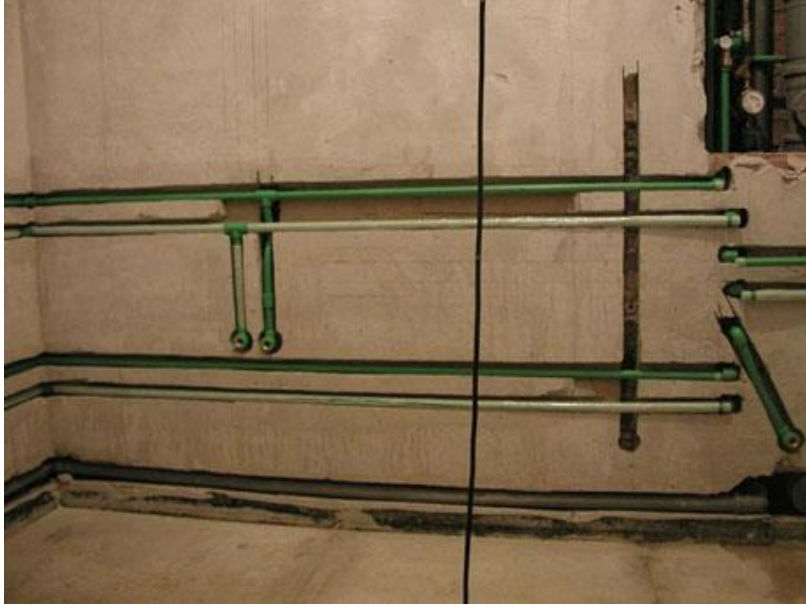
Şəkil 3.18. Sxema uyğun olaraq divarda kəsmə işlərinin aparılması
