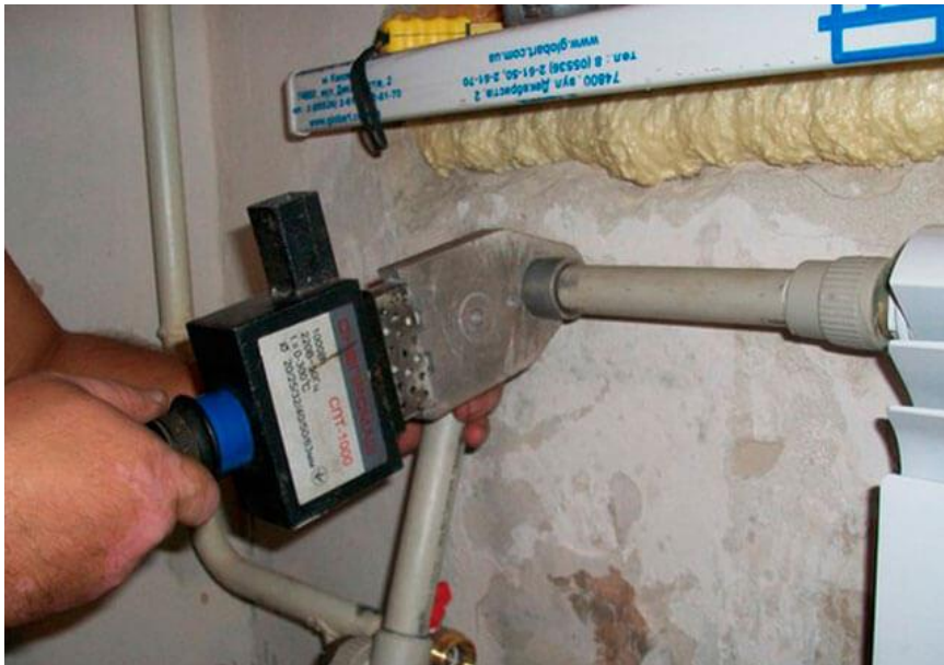
Şəkil 3.11. Narahat yerlərdə borunun qaynağı
