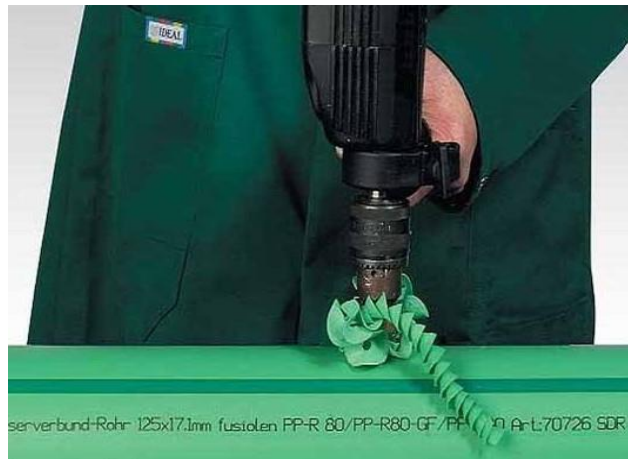
Şəkil 3.13. Boru üzərində deşiyin və faskanın açılması
